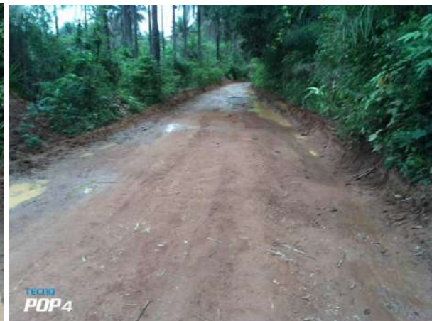
Remise en état
