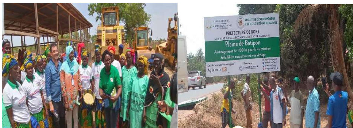
Mission d'appui GMB aux infrastructures Implantation panneaux de visibilité
