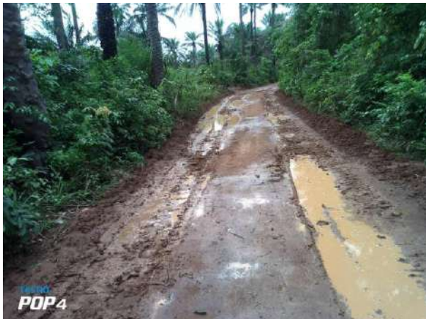
Etat de dégradation
